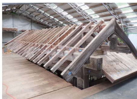
小屋組取外し
