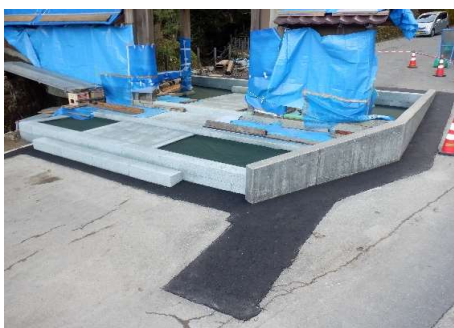
アスファルト舗装
