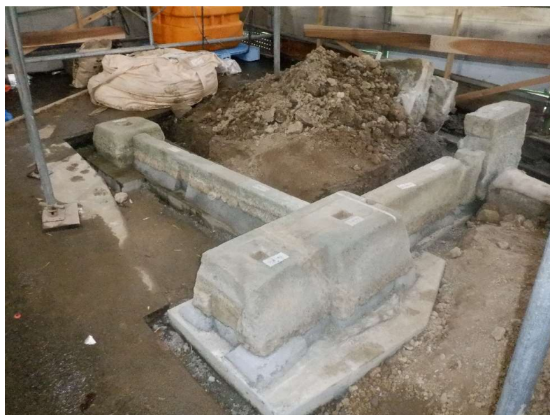
工事完了(右側)
