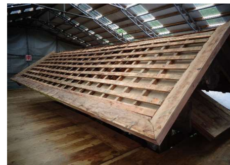
小屋組取外し
