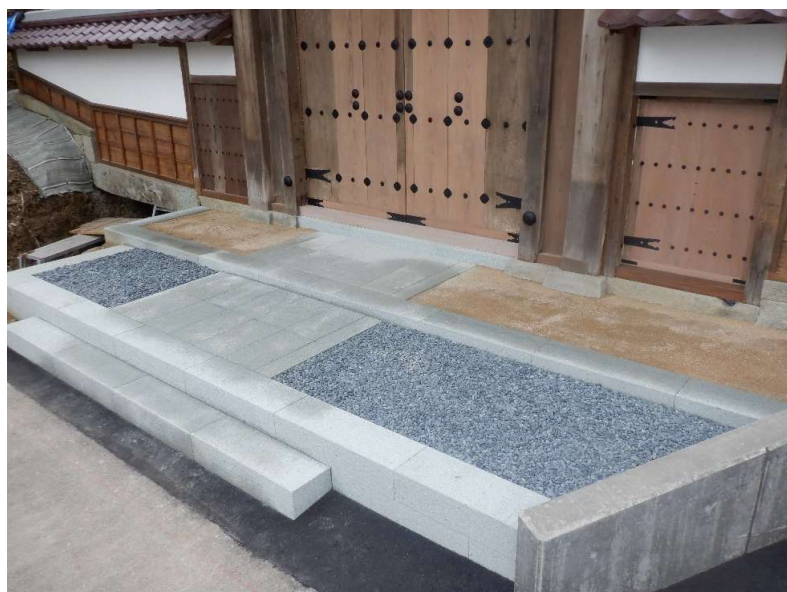
工事完了(正面)
