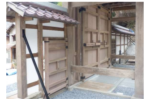
工事完了(背面)
