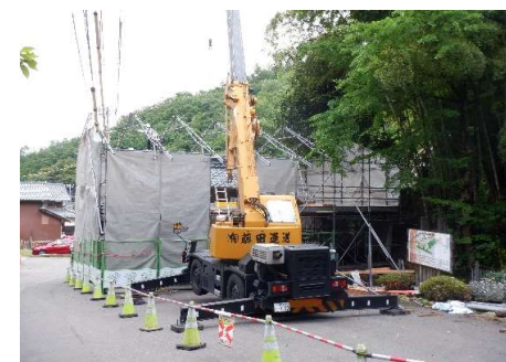
屋根下地梁枠組
