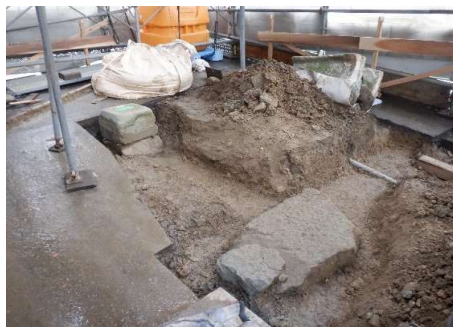
周囲掘削・基礎石取外し
