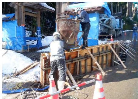
コンクリート擁壁打設
