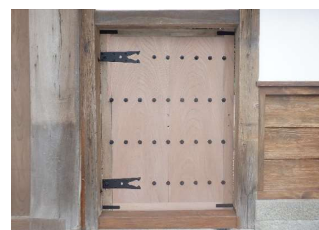
工事完了(潜戸正面)
