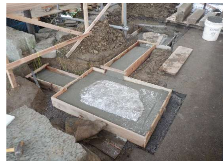
根石根巻コンクリート打設
