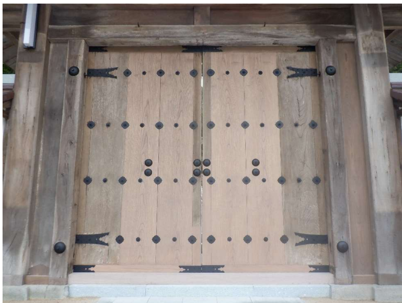
工事完了(大扉正面)
