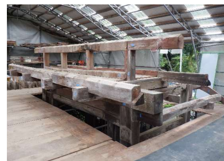
小屋組取外し
