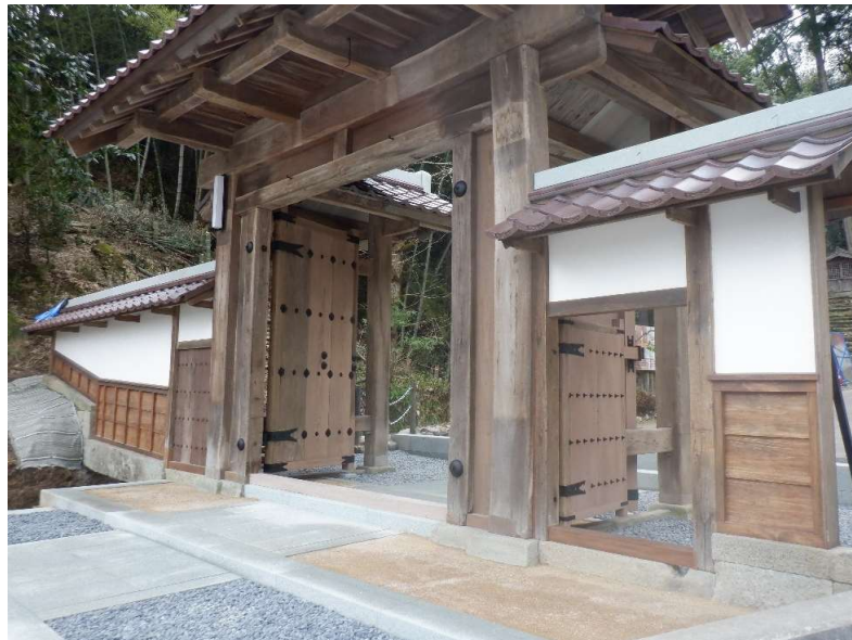
工事完了(正面)
