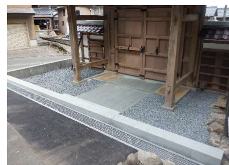
工事完了(背面)
