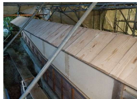
工事完了(袖塀)
