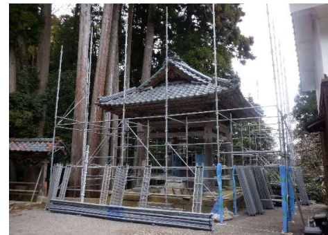
外部足場組立
