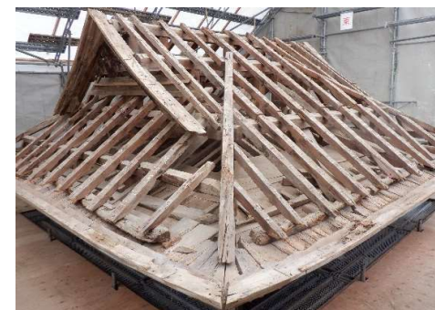
野地板取外し完了
