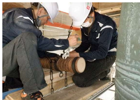
撞木吊金具取付
