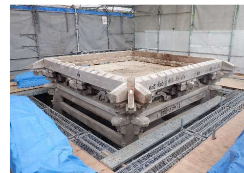
軒廻り取外し完了
