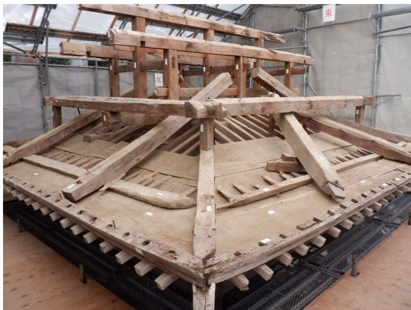
野垂木取外し完了
