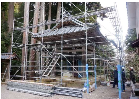
外部足場組立
