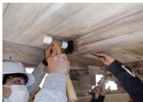
鎖吊金具取付
