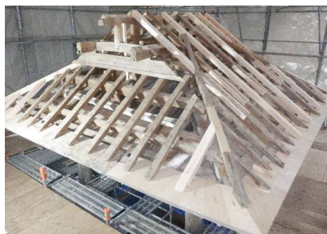
こけら葺下地材取付前
