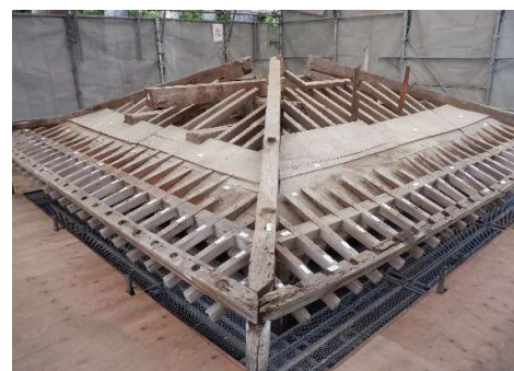
小屋組取外し完了
