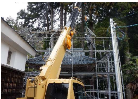
屋根下地梁枠組立
