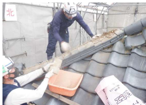
屋根瓦取外し
