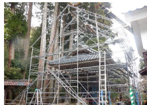
屋根下地梁枠組立
