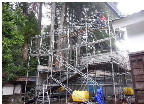
屋根下地梁枠組立
