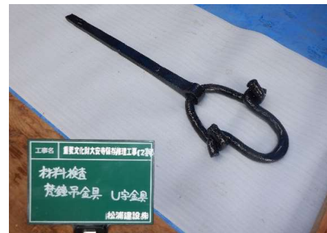
U字金具補修
