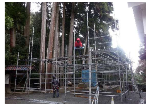
外部足場組立
