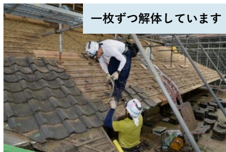
屋根瓦解体中
