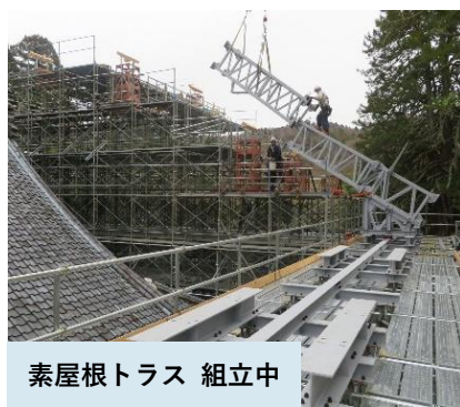
スライド工法によるトラス組立
