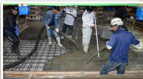
コンクリートで固めた基礎
