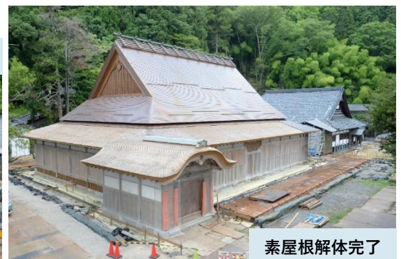
周辺足場が解体
