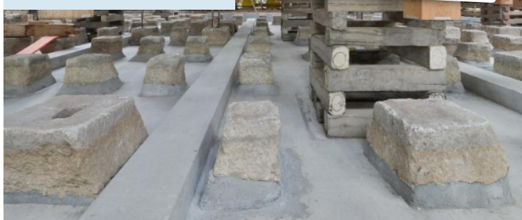
コンクリートで固めた基礎
